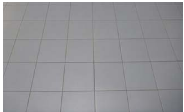
1 Vor 1990 eingesetzter Plattenkleber kann Asbest enthalten.
