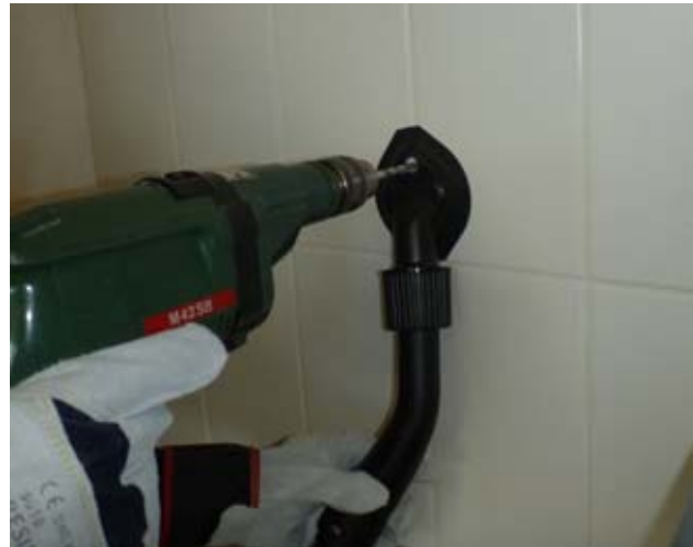
4 Bohrmaschine mit Quellenabsaugung im Einsatz an Keramikplatten mit asbesthaltigem Kleber
