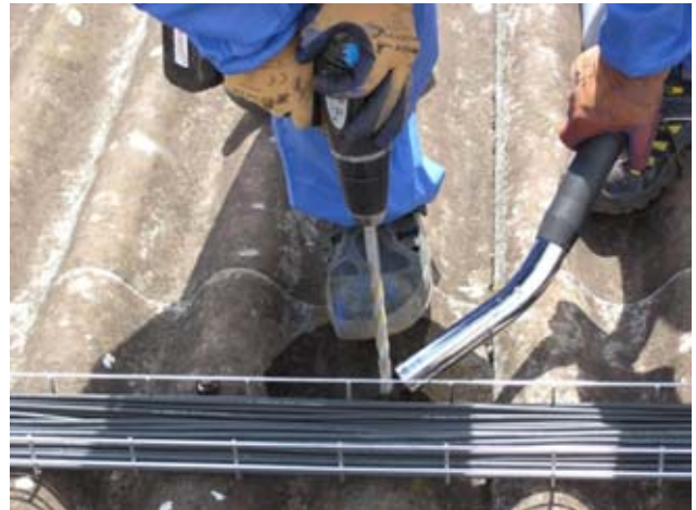
5 Faserzement befeuchten, Löcher mit niedriger Drehzahl bohren und Quellenabsaugung einsetzen.
