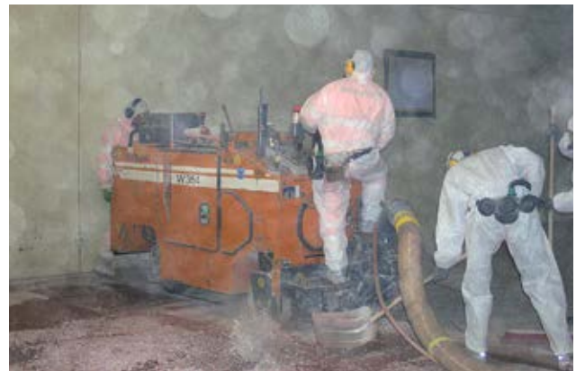
1 Belagsfräse (Typ «Reprod») angeschlossen an Entstaubungsanlage (Staubklasse H)
