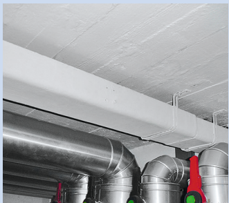
Kabelkanal aus Asbestzement
