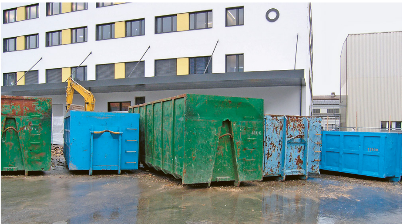
Abfallmulden für Asbest
