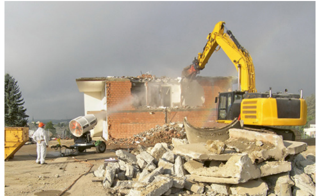
Rückbau mit einem Hydraulikbagger
