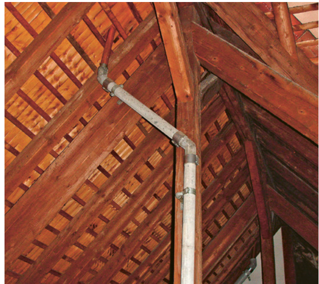
Asbesthaltige Faserzementleitungen
