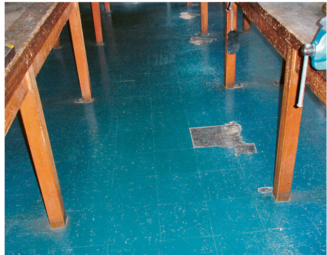
Asbesthaltiger Bodenbelag
