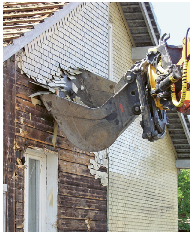
Asbesthaltige Faserzementschindeln
