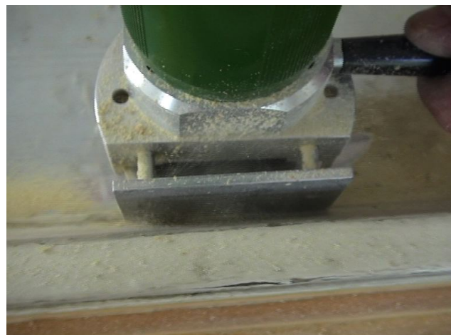
1 Entfernen von Fensterkitt mit einer Fugensäge
