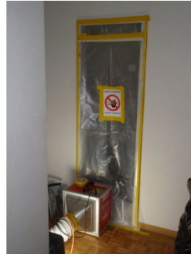
5 Abgetrennte Sanierungszone mit Unterdruckgerät
