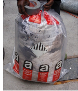
6 Kunststoffsack mit der Kennzeichnung Asbest
