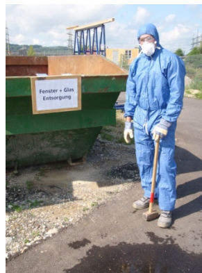
2 Arbeiter mit korrekter persönlicher Schutzausrüstung
