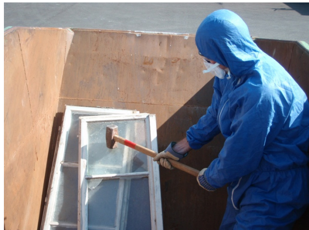
1 Ausglasen mit einem Hammer
