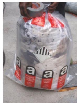
6 Kunststoffsack mit der Kennzeichnung Asbest
