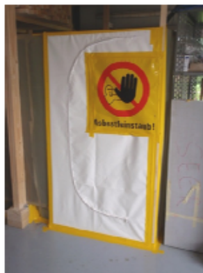
5 Sauber abgetrennter Arbeitsbereich
