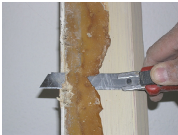
4 Abtrennen des Kitts von der Unterlage mit einem Japanmesser
