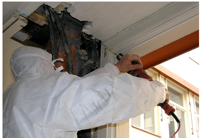
1 Aufschneiden des Fensterrahmens mit einer Fuchsschwanzsäge
