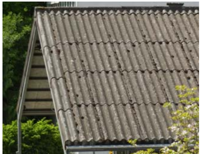
1 Wellplatten aus asbesthaltigem Faserzement
