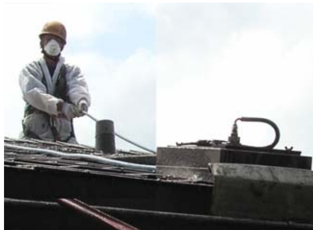
4 Asbestflächen-Reinigungssystem mit geregelter Wasserkreislauf
