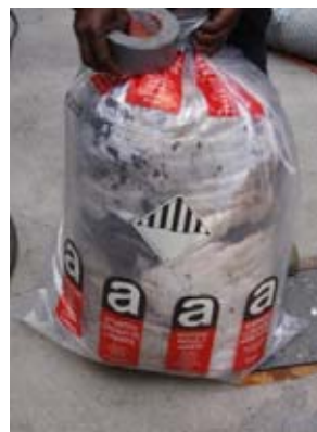
6 Kunststoffsack mit der Kennzeichnung «Asbest»
