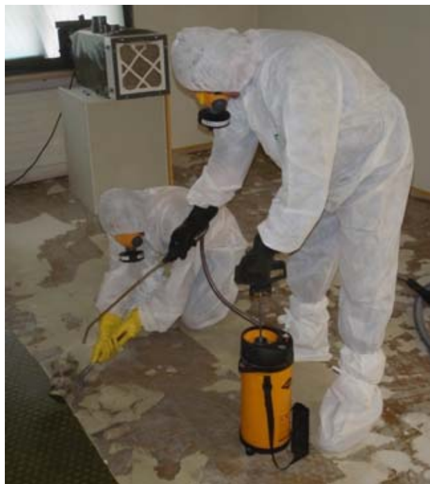
5 So wird der Belag entfernt.
