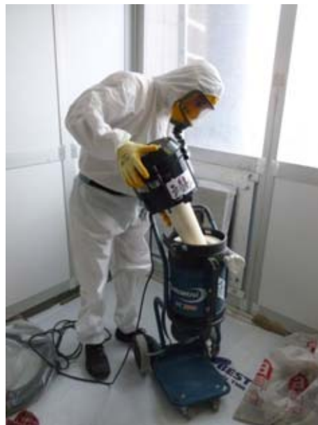
5 Periodische Kontrolle und Unterhalt des Apparats innerhalb eines abgegrenzten Bereichs durch eine spezialisierte Asbestsanierungsfirma
