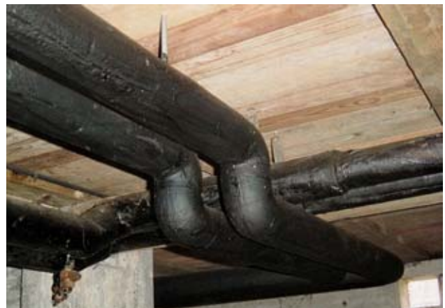
1 Diese Isolation mit bituminösem Anstrich lässt sich mit dem Cutter leicht aufschneiden und entfernen.
