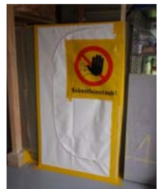
3 Dieser Arbeitsbereich ist sauber räumlich abgetrennt und gekennzeichnet.
