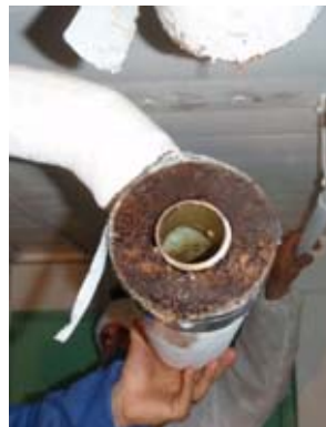
7 Abgeschnittenes Rohr, das noch mit Kunststoffolie eingepackt wird
