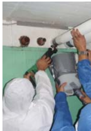
4 Schneiden eines Rohres mit der Fuchsschwanzsäge
