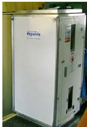
2 Eingang zur Sanierungszone (Schleuse, abgedichtet)
