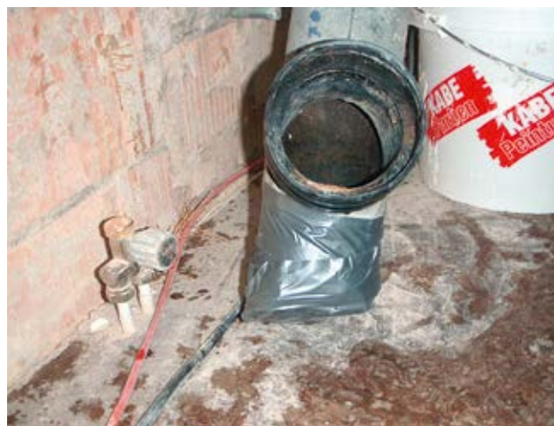
4 Abgeklebte Bruchkante, vorbereitet für die Entsorgung.
