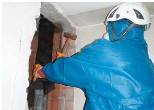
1 Ein Asbestzementrohr wird mit einem kontrolliertem Hammerschlag gebrochen.
