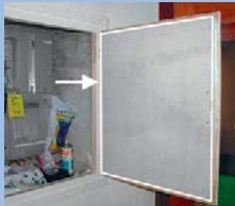
Asbesthaltige Brandschutzplatte
