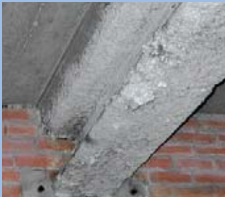
Spritzasbestisolierung
