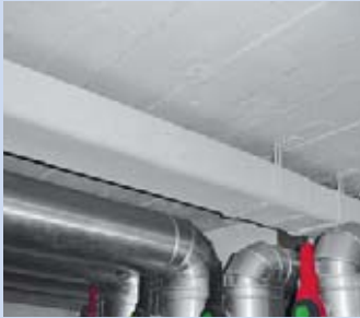
Kabelkanal aus Asbestzement
