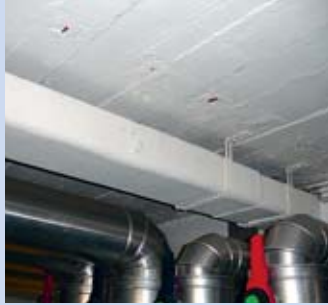
Kabelkanal aus Asbestzement
