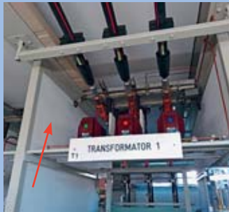
Brandschutzplatten als Trennwand
